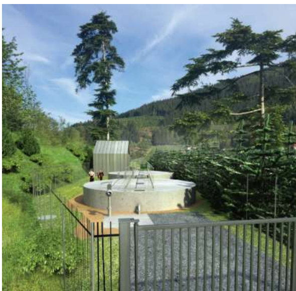
Ventron : Mission AMO suivi d'un programme de travaux d'assainissement. Construction d'une STEP.
