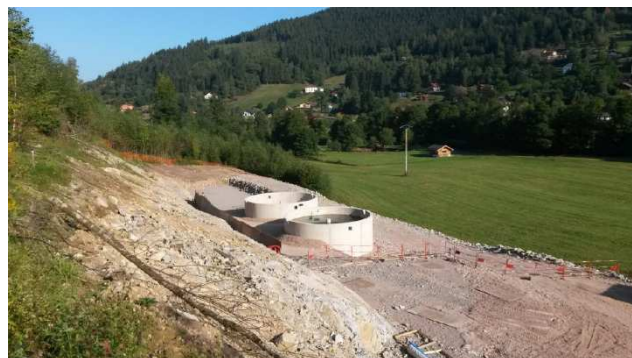
Ventron : Travaux de construction d'une station d'épuration
