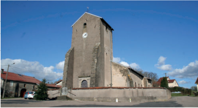
BOUZEMONT RENOVATION DE L'ÉGLISE (TOUR ET BAS-COTES)
