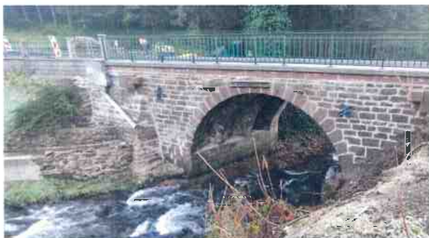
Moussey Réfection du pont de la Folie
