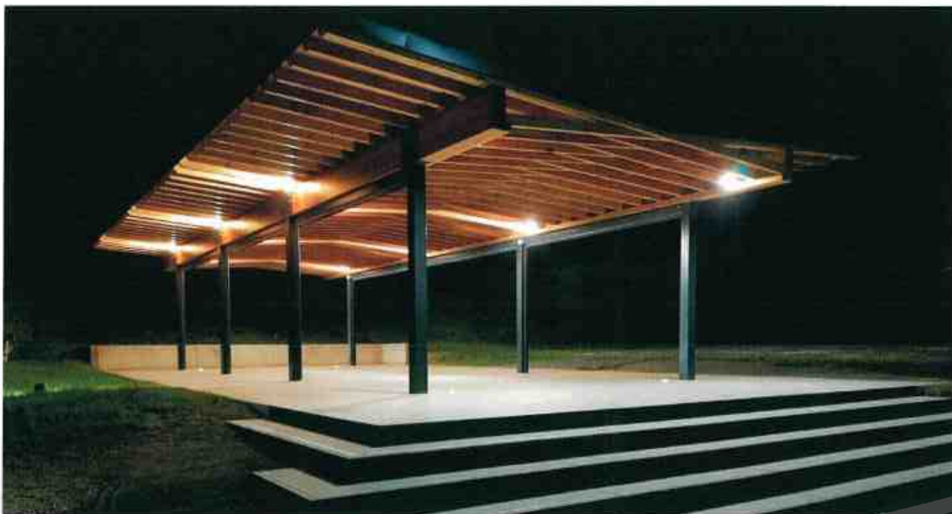
Romont - Construction d'un Hall de convivialité
