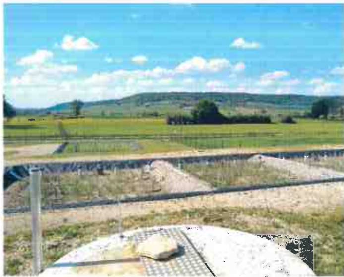
➔ Ruppes (SIEA des Côtes et la Ruppe) Construction d'une station de traitement des eaux usées
