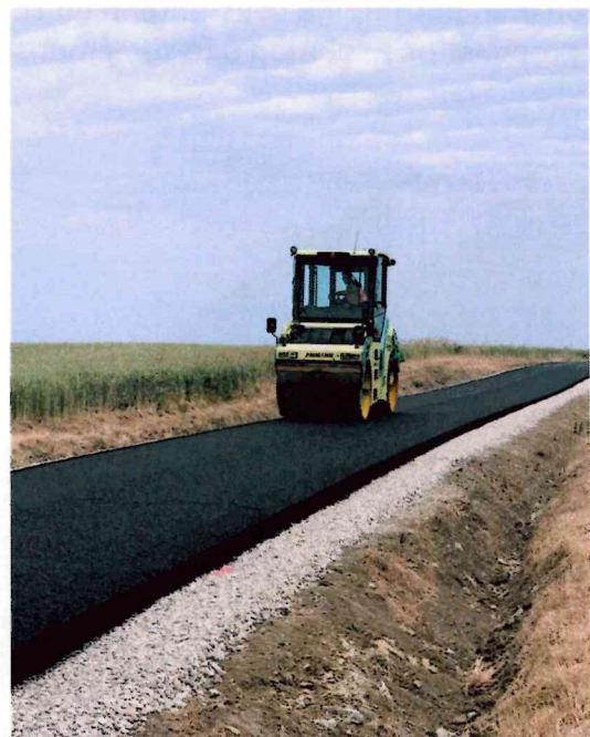
Réfection de la voirie communale – SENONGES
