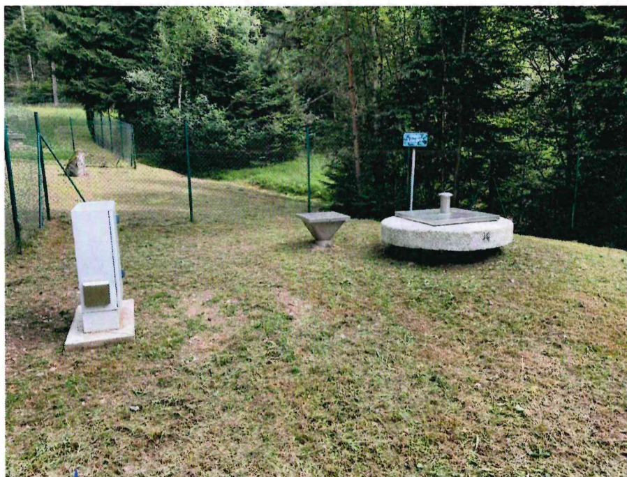
Construction d'une station de pompage – BELMONT-SUR-BUTTANT
