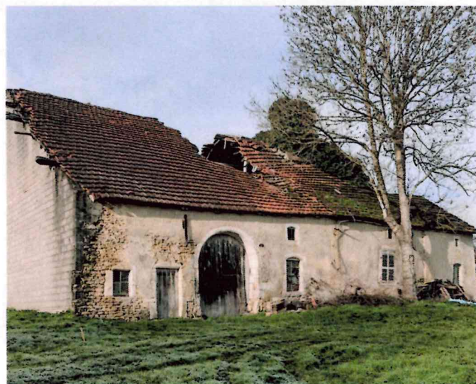
Ancienne ferme Vosgienne - BATI-DEGRADE
