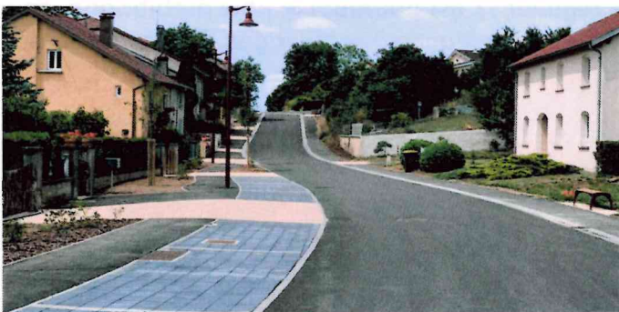
Aménagement de la petite They – THEY-SOUS-MONTFORT
