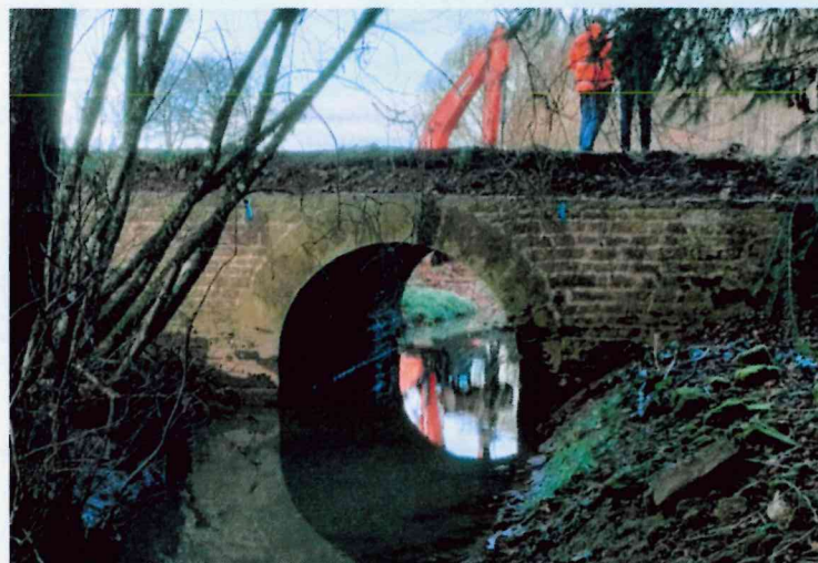
Réfection du Pont - HAROL
