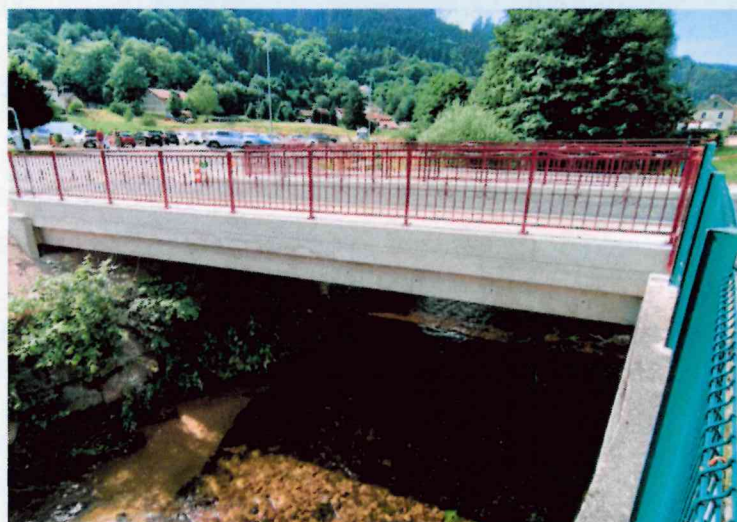
Réfection du Pont - PLAINFAING
